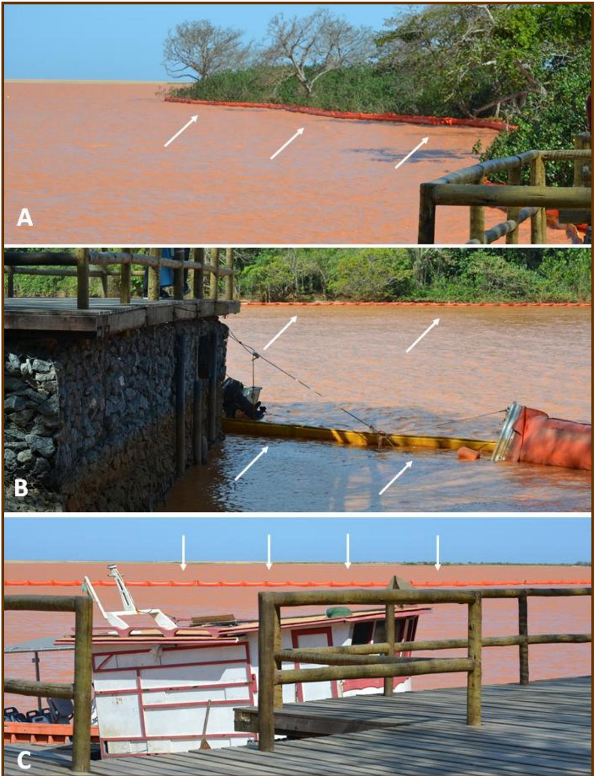
**Figura 20.** A e B - vista das boias de contenção de óleo instaladas na borda do manguezal e C - boias instaladas na costa em RG. Fotos: Valéria S. Quaresma.
