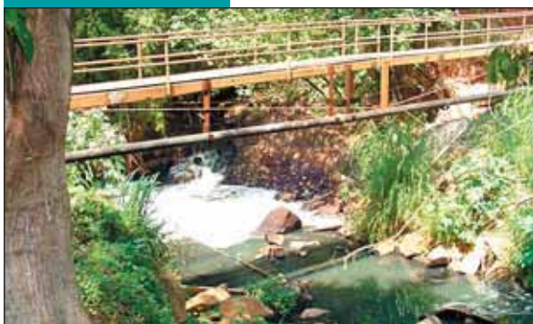
Ribeirão urbano com carga de esgoto doméstico e lixo.
