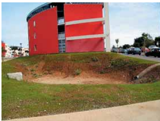
Reservatório de retenção da água escoada em telhados e estacionamentos devido a construção de edifício residencial
