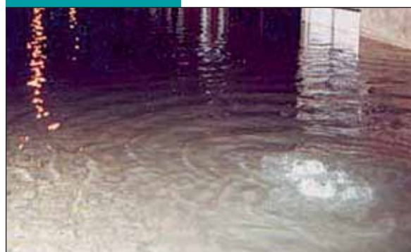
Rua alagada após a ocorrência de uma chuva. No canto inferior direito, observa-se que a boca de lobo “fornece” água à rua (água “brotando” por turbilhão) ao invés de drená-la.
