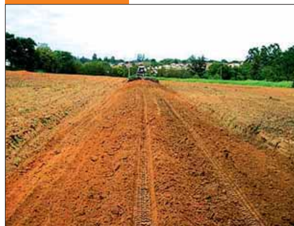
Terraço em construção em área de pastagem.
