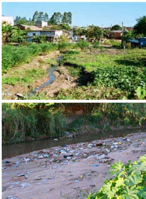
Assoreamento intenso do canal fluvial por sedimentos e lixos em áreas urbanas. (Campinas, SP).
