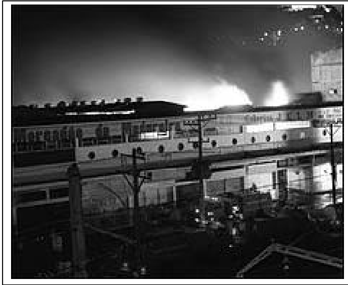
Fig. 15 - Incêndio do Mercadão de Madureira
