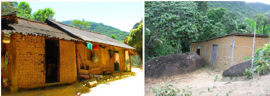
Figuras 89 e 90 – Estrutura das casas de pau a pique com mesclas de novos objetos da urbanidade.
