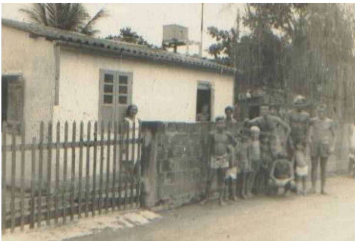
Figura 33: Construção de alvenaria na Colônia. Foto cedida por José Luiz de Castro Ferreira. Data desconhecida.
