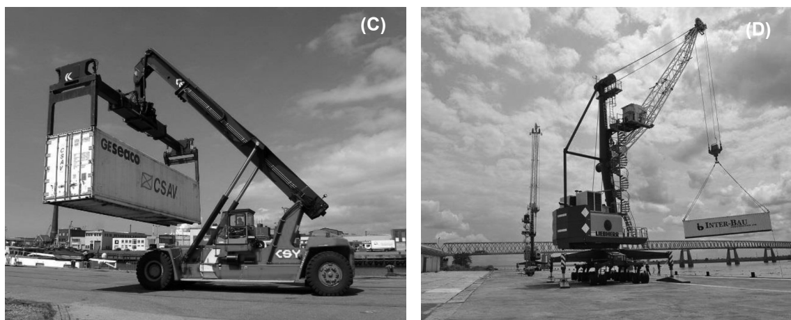
Figura 2.3-2: Exemplo dos equipamentos em operação no Terminal Sepetiba TECON: (A) Portêineres; (B) Rubber Tyred Gantry Cranes ; (C) Reach Stacker e (D) Mobile Harbour Cranes .
