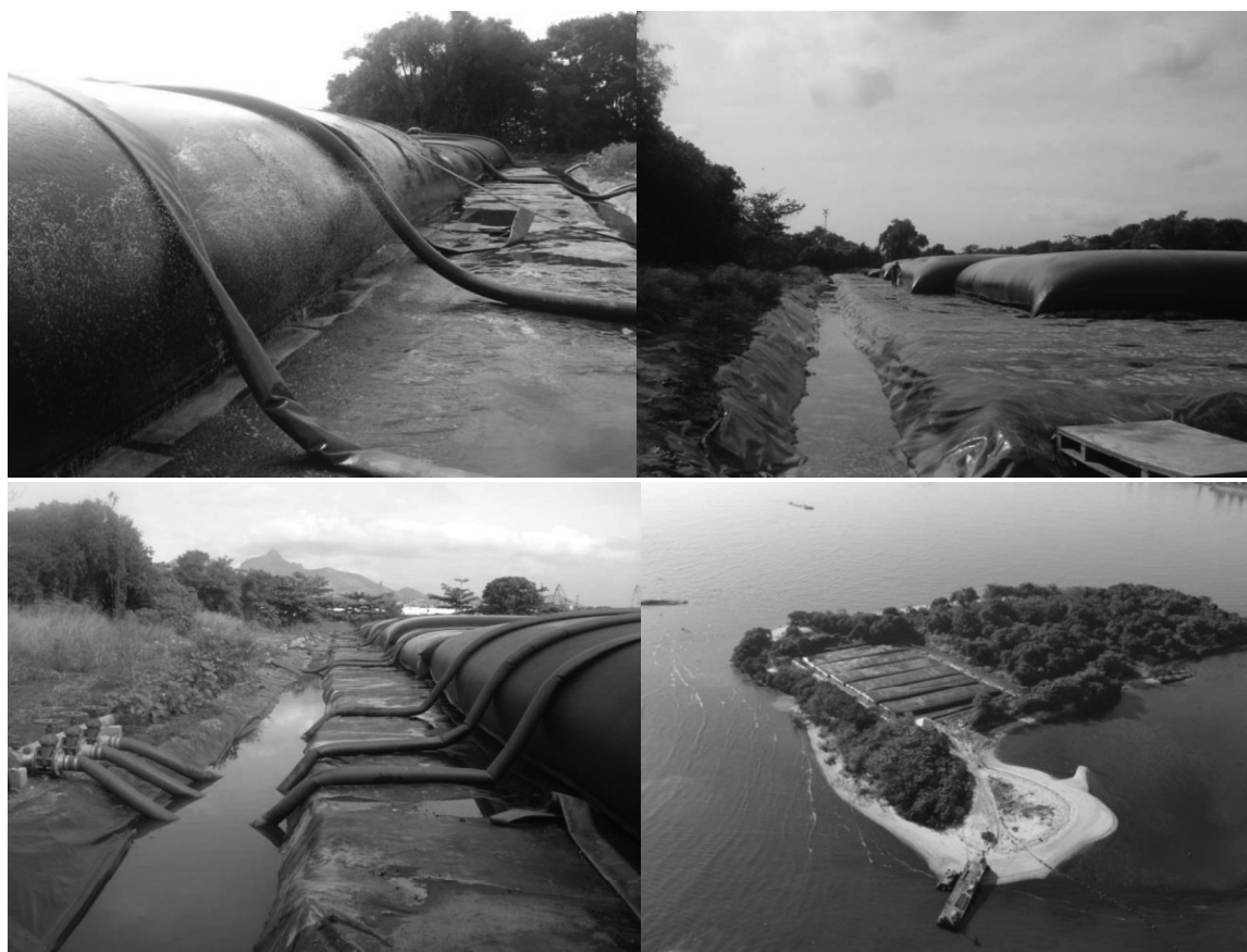
Figura 2.1-15: Encapsulamento do material contaminado na Ilha da Pombeba durante a dragagem do Porto do Rio de Janeiro. Fonte: CONCREMAT, 2012.
