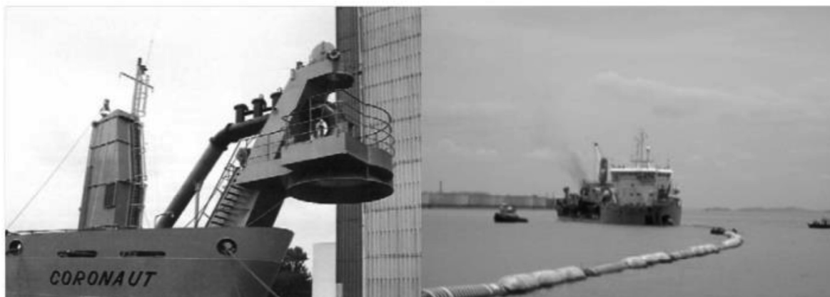
Figura 2.1-13: Descarte do material pela tubulação de descarregamento da cisterna, com a utilização da bomba de dragagem.
