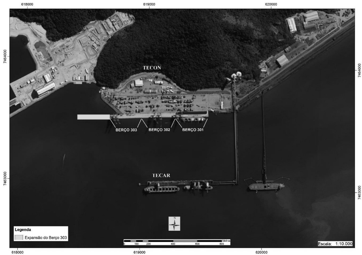
Figura 2.3-1: Imagem aérea dos terminais operados pela CSN na Baía de Sepetiba.
