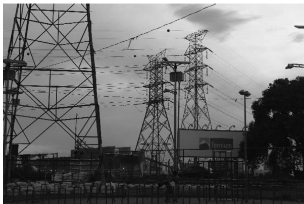
Figura 3.4-18: Área industrial da empresa siderúrgica Companhia Siderúrgica do Atlântico (CSA), atualmente Ternium.
