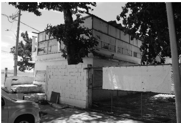
Figura 3.4-15: Sede da APAS, em Sepetiba.
