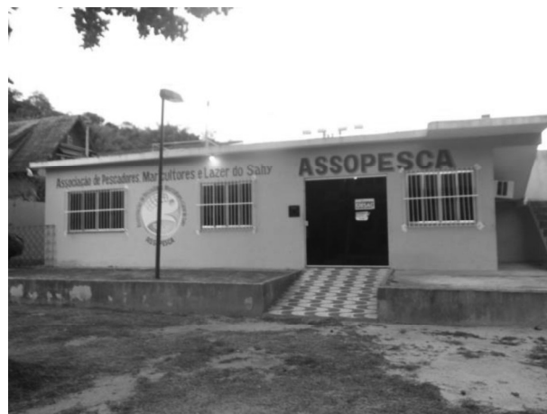
Figura 3.4-27: Sede da Assopesca, em Mangaratiba.
