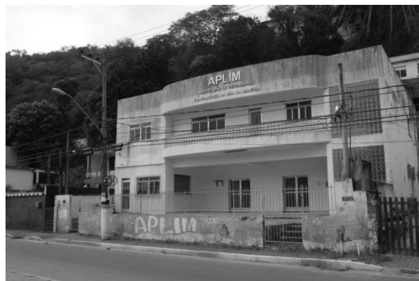
Figura 3.4-23: Sede da Aplim, na Ilha da Madeira, em Itaguaí.
