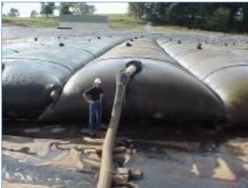
Figura 7: Processo de bombeamento do material dragado para o Geobag
