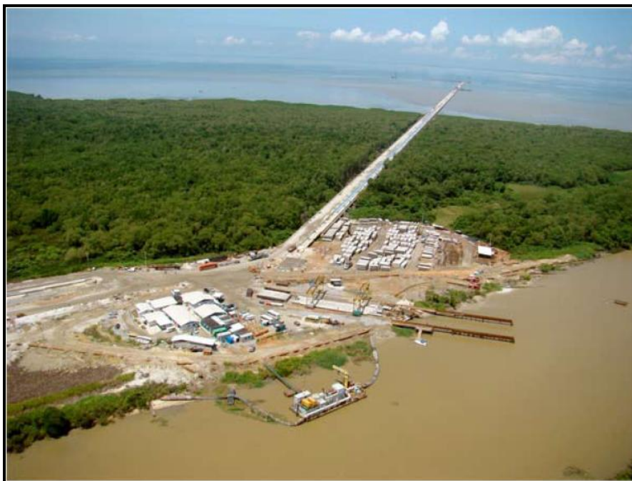
Figura 3- Instalação da TKCSA em meio ao manguezal (FRL, 2008).
