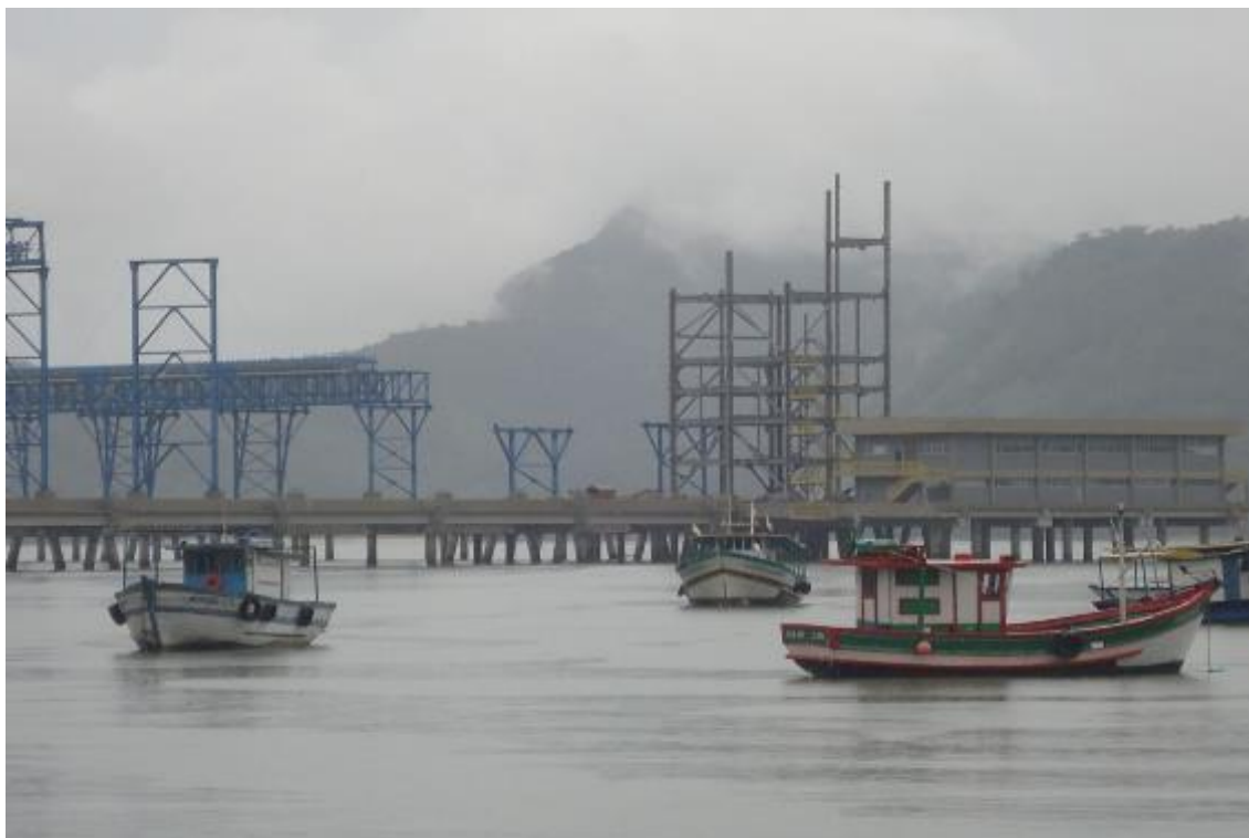
Figura 2 – Obras do Porto Sudeste (MMX) – Itaguaí
