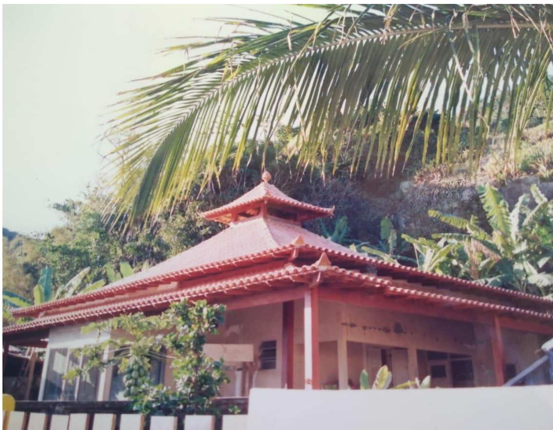
Figura 57: Telhado da casa 09 após reforma. Acervo familiar. 2000 (circa).
