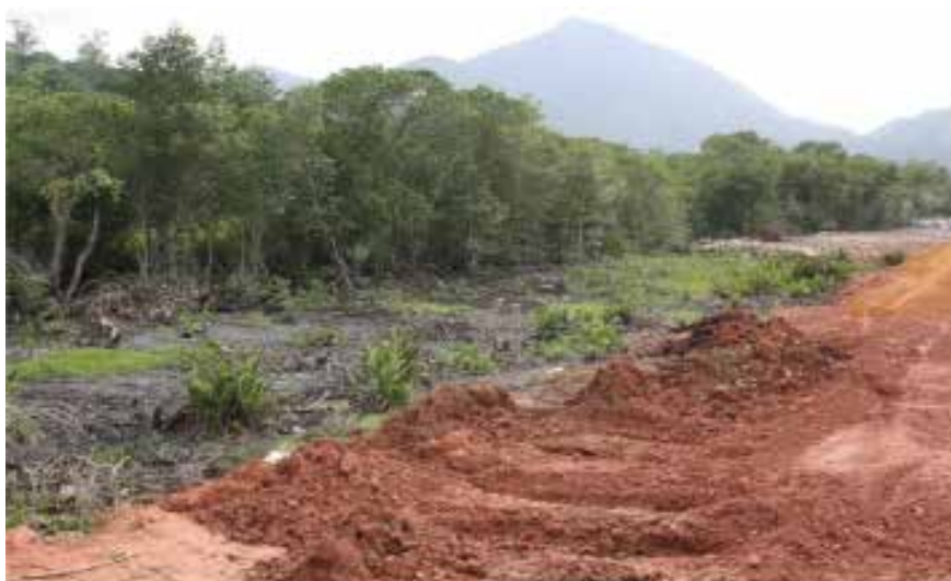
Figura 8 - Intervenções nos limites da Reserva Biológica Estadual de Guaratiba, para duplicação da Avenida das Américas (Fonte: arquivo pessoal NEMA/UERJ).
