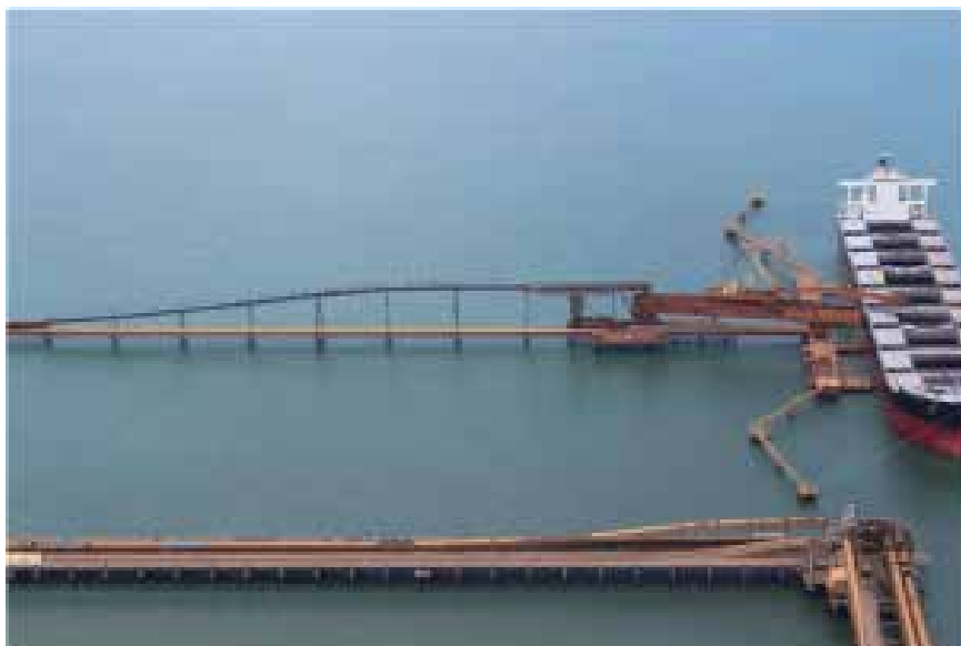
Figura 6 – Terminal CPBS do Porto de Itaguaí. Fonte: Trabalho de campo NUTEMC, 2017.
