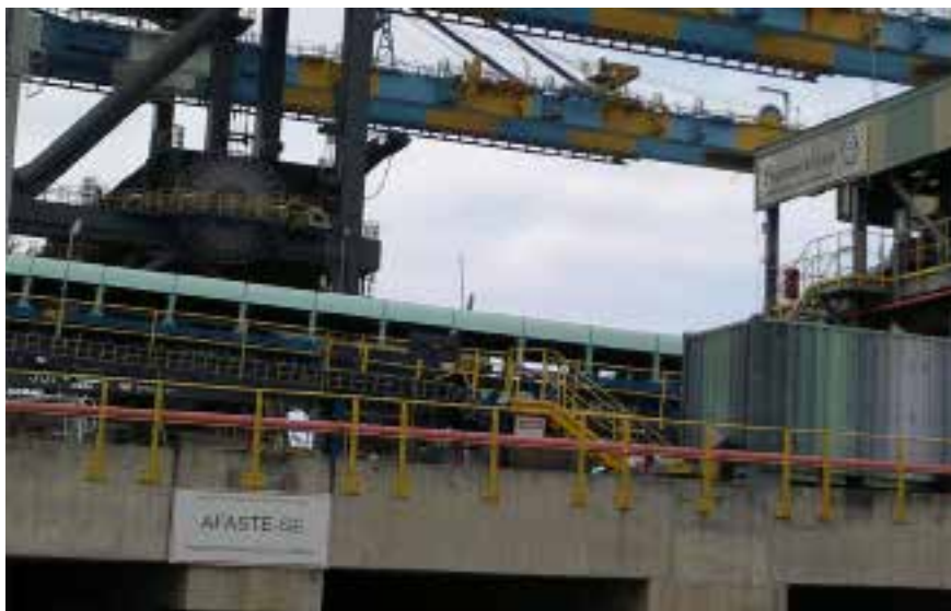
Figura 15 – Pier de atracação do Porto da Thyssenkrupp (TKCSA) com aviso onde se lê: “Área de Segurança Pública Portuária – Proibida atracação e fundeio – AFASTE-SE”. Foto: DOMINGOS, P., 2012.
