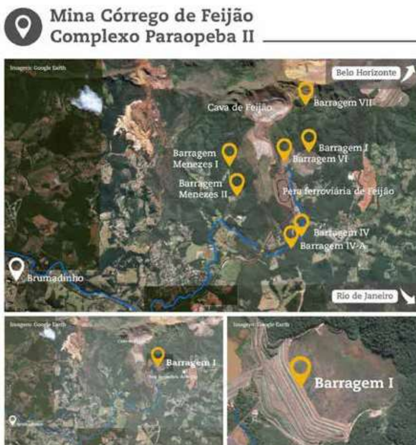
Figura 56 – Operações da mineradora Vale S. A. em Brumadinho Fonte: PORTAL R7 (2019)
